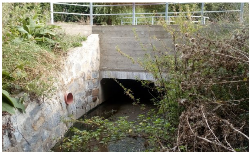
Cestní mostek – pohled ve směru proti toku
