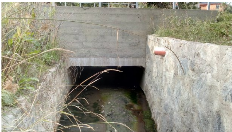
Cestní mostek – pohled ve směru toku
