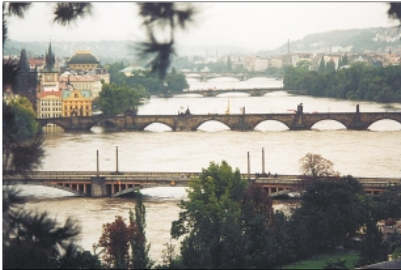
Celkový pohled na rozvodněnou Vltavu Overall view of the swollen Vltava River
